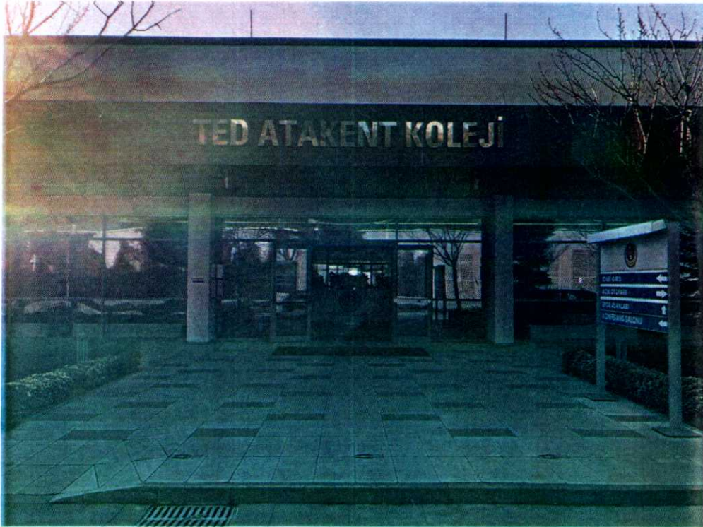
RESİM 1-BİNA DIŞ CEPHE GÖRÜNÜŞÜ
